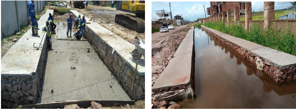
Figura 15: Secção transversal da vala de Minguene em construção; Fonte: Autor
