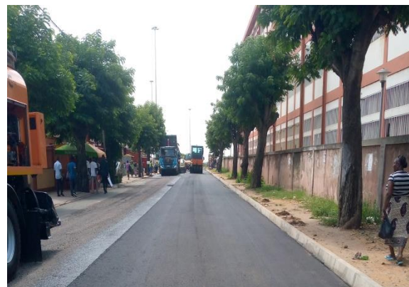
Figura 36: Compactação do betão betuminoso com o cilindro pneumático; Fonte: Autor
