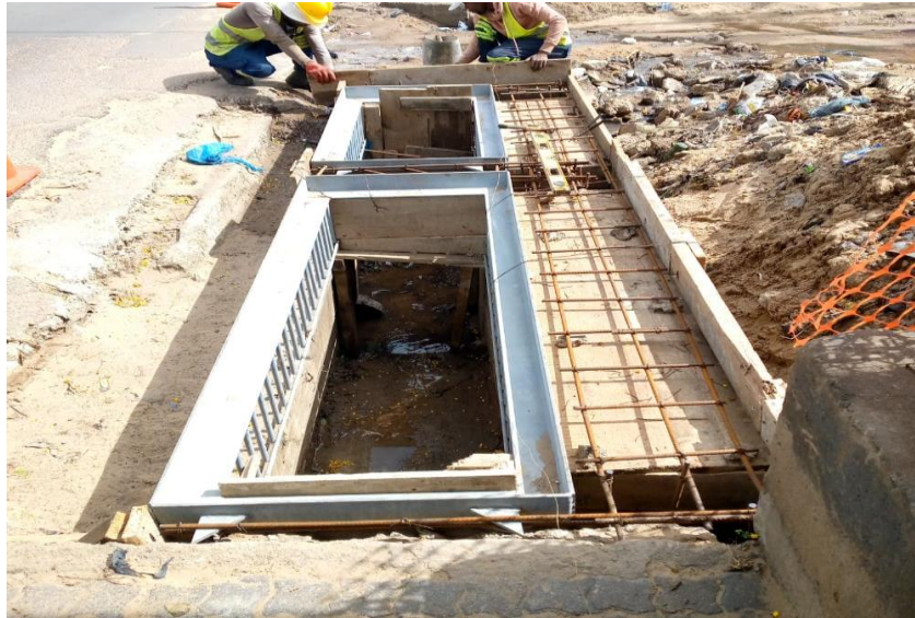
Figura 40: Construção de sarjetas; Fonte: Autor
