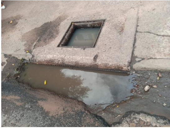
Figura 17: Sarjetas assoreadas: Fonte autor
