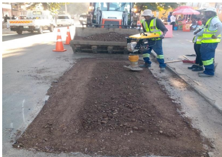
Figura 27: Aterro e compactação da base granular; Fonte: Autor
