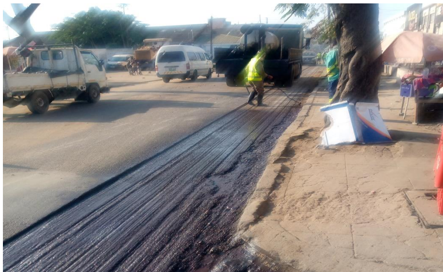
Figura 33: Aplicação da rega de impregnação com MC 30; Fonte: Autor
