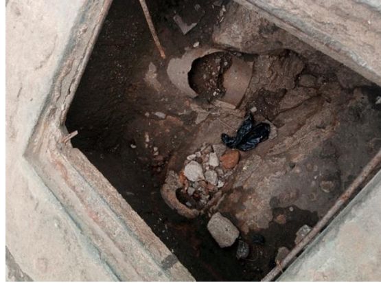
Figura 17: Sarjetas assoreadas: Fonte autor
