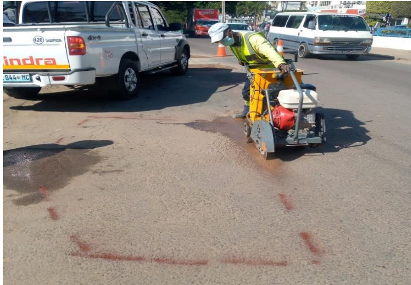
Figura 25: Demarcação e corte da área patológica; Fonte: Autor
