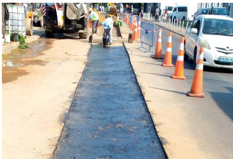
Figura 28: Aplicação da rega de colagem; Fonte: Autor
