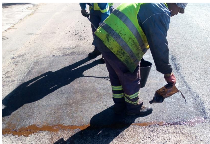
Figura 30: Selagem do bordo do remendo com emulsão; Fonte: Autor
