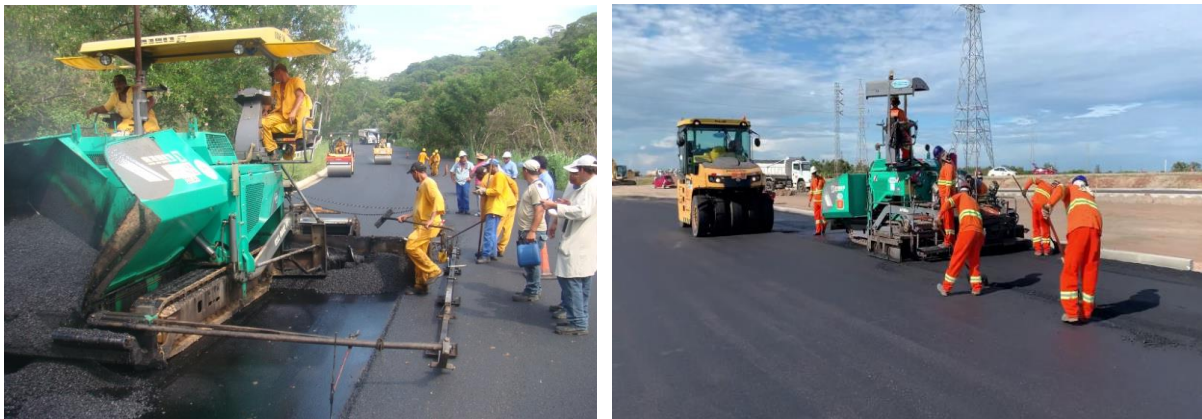
Figura 6: Pavimentação com mistura betuminosa a quente; Fonte: (Figueiredo, 2011)
