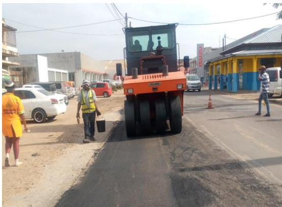
Figura 36: Compactação do betão betuminoso com o cilindro pneumático; Fonte: Autor
