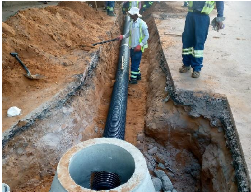
Figura 38: Colocação de colectores plástico; Fonte: Autor
