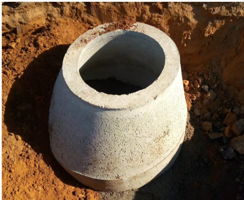
Figura 39: Construção de caixas de inspecção; Fonte: Autor
