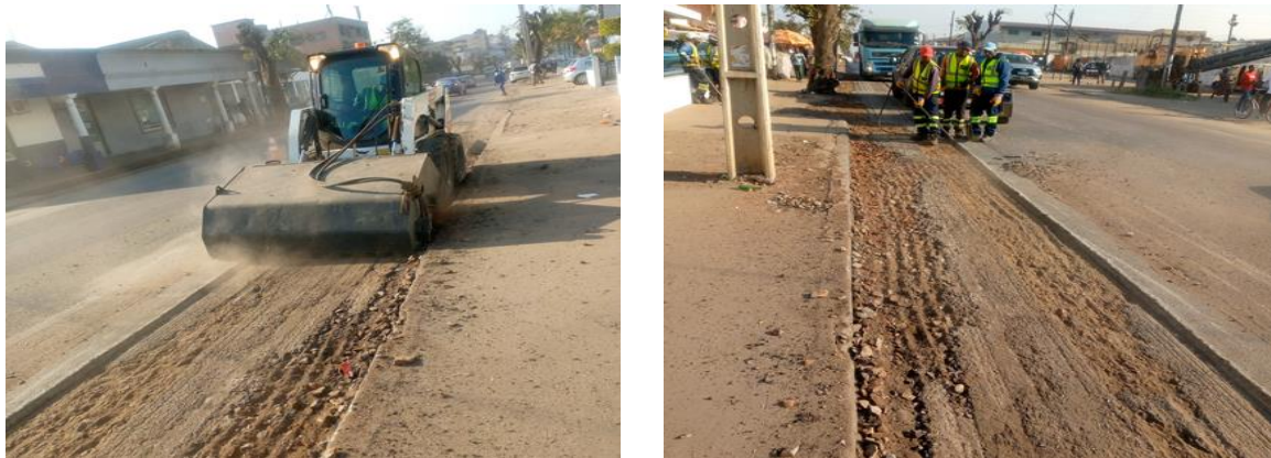
Figura 32: Limpeza do material fresado; Fonte: Autor
