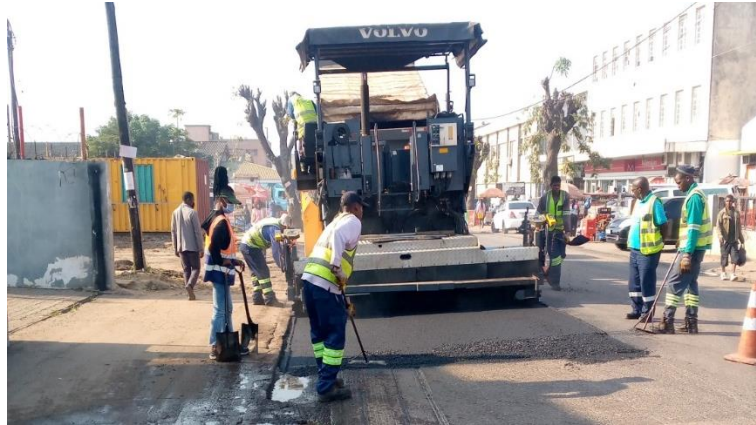
Figura 34: Aplicação do betão betuminoso a quente; Fonte: Autor
