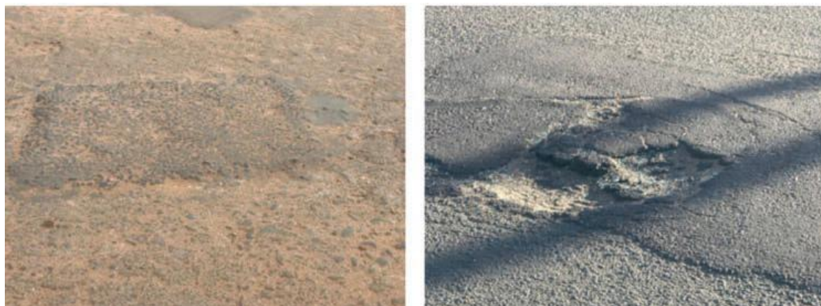
Figura 21: Remendos na Av. de Trabalho; Fonte: Autor
