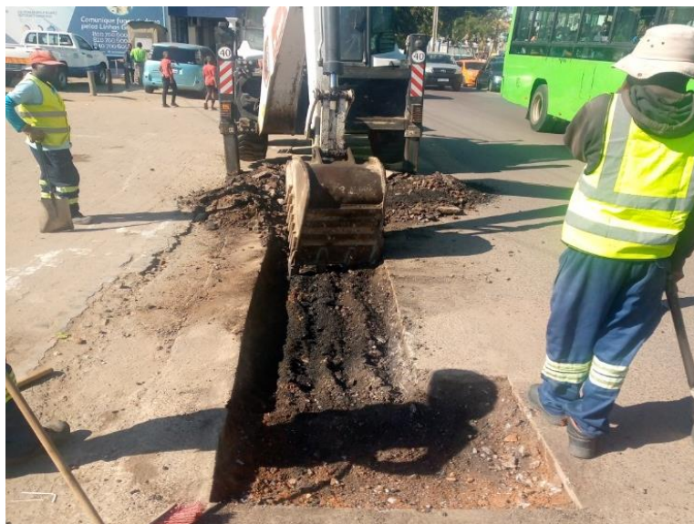
Figura 26: Remoção do material danificado na área patológicas; Fonte: Autor
