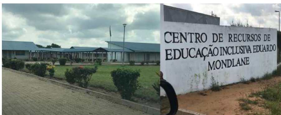
Figura 6 - Vista frontal do edifício geral do CREI- Macia/Gaza
