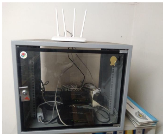
Figura 2: Roteador principal que recebe dados, adaptador PoE e switches para compartilhar dados pela faculdade.
