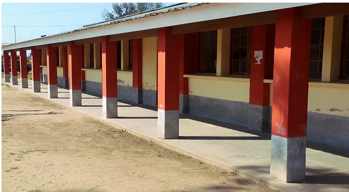
Figura 8: Bloco 03 das salas da ESEMA
