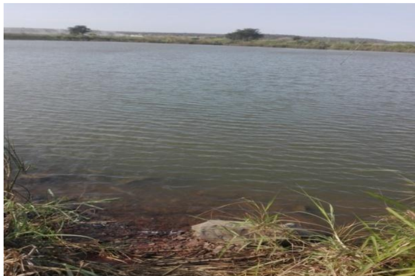
Figura 9. Reservatório Principal (Fonte: Autor).
