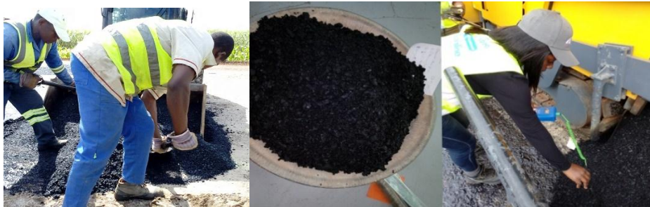
Figura 12: Colecta da mistura betuminosa, (camada de revestimento).
