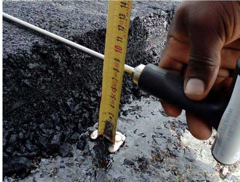
Figura 19: espessura da camada de revestimento aplicada no pavimento em estudo
