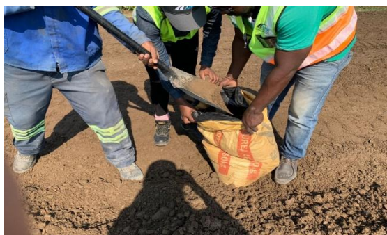
Figura 11: Colecta do material da base estabilizada.
