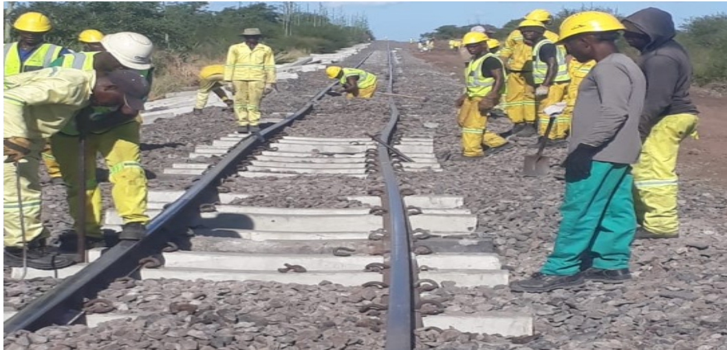
Figura 34: Trabalhos de retificação da linha no trecho Moamba - Secongene (Fonte: Autor, 2022)
