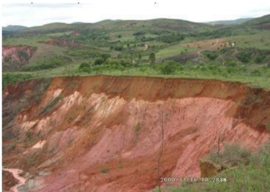
Figura 10: Ruptura de talude por escorregamento (fonte Gerschocovit)
