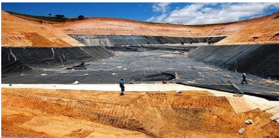
Figura 38: Construção de um aterro sanitário.
