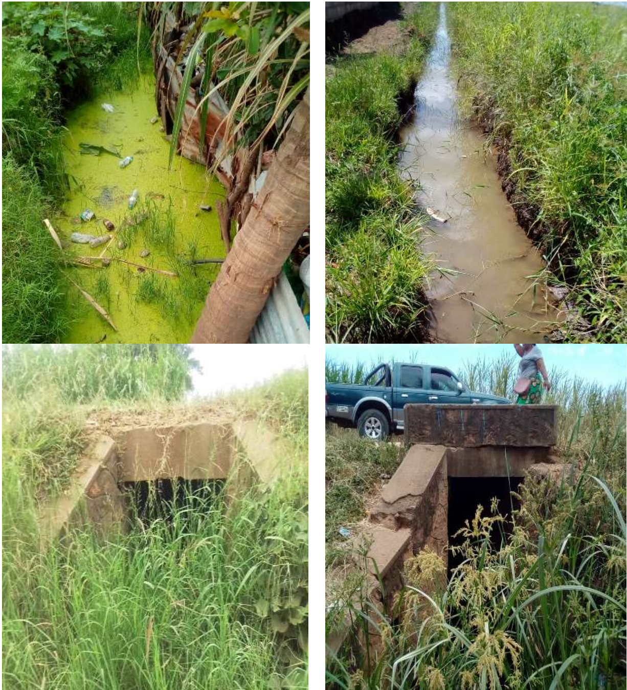
Figura 12. Obras hidráulicas existentes na área de estudo Fonte: autor
