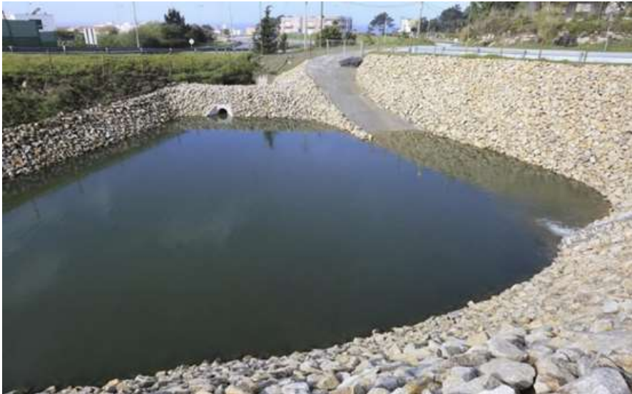
Figura 7 Bacia de Retenção - Vila Praia de Âncora, Fonte: Wikipedia acessado as 17:50 17-03-2022
