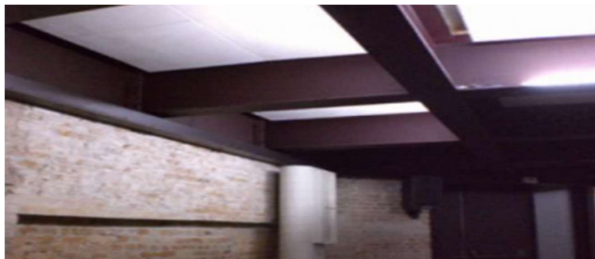
Figura. 12: Reforço da laje, com uso de perfis horizontais
