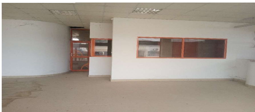
Figura. 9: Imagem interior do edifício Fonte: Autor (2022)
