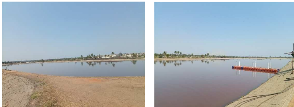
Figura 4.10. Lagoa facultativa da ETAR do Infulene em construção (Fonte: Autor)
