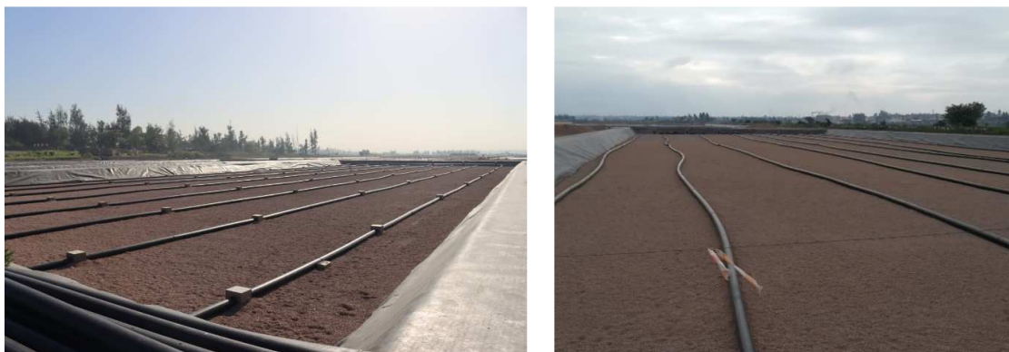
Figura 4.12. Leitos de Macrófitas da ETAR do Infulene em construção (Fonte: Autor)
