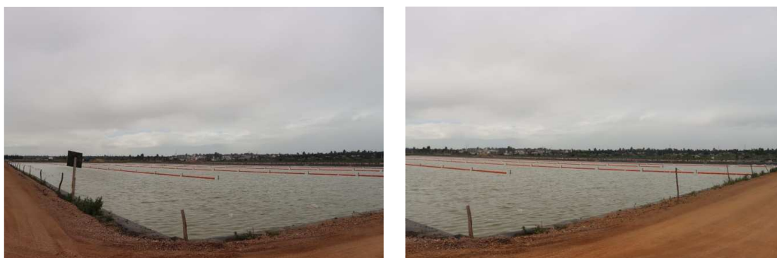
Figura 4.11. Lagoas de Maturação da ETAR do Infulene em construção (Fonte: Autor)
