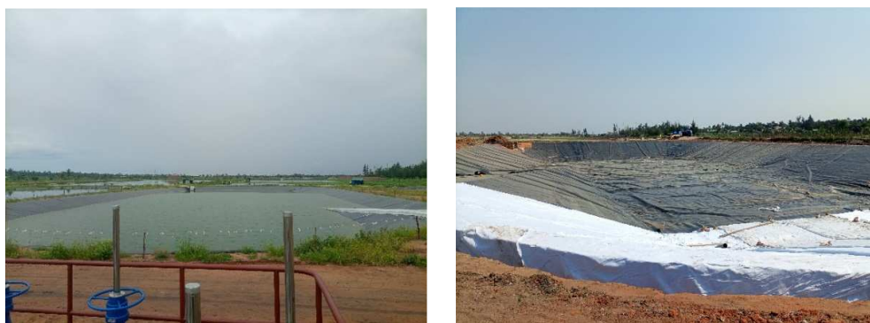
Figura 4.9. Lagoa anaeróbia da ETAR de Infulene em construção (Fonte: Autor)
