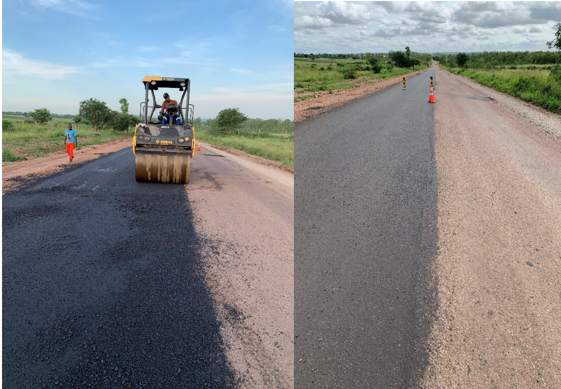
Figura 30. Compactação e abertura ao trafego. (Autor 2021. )
