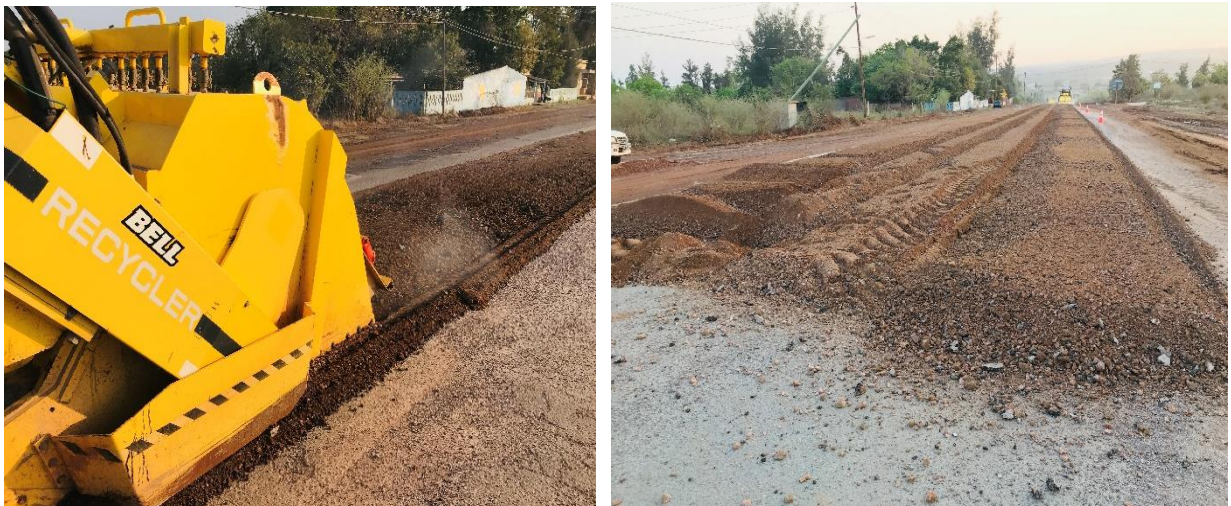
Figura 26 Escarificação e reciclagem do pavimento incluindo a base Km 5+700. (Autor 2021.)
