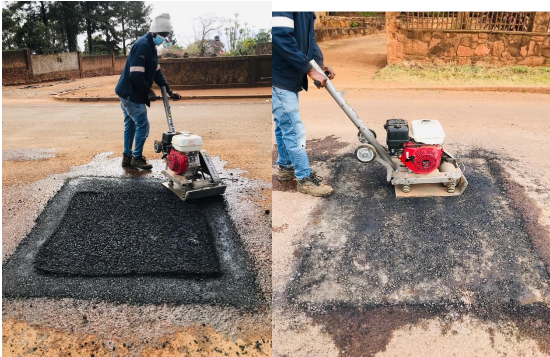
Figura 41. Processo de Compactação. (Autor 2021.)
