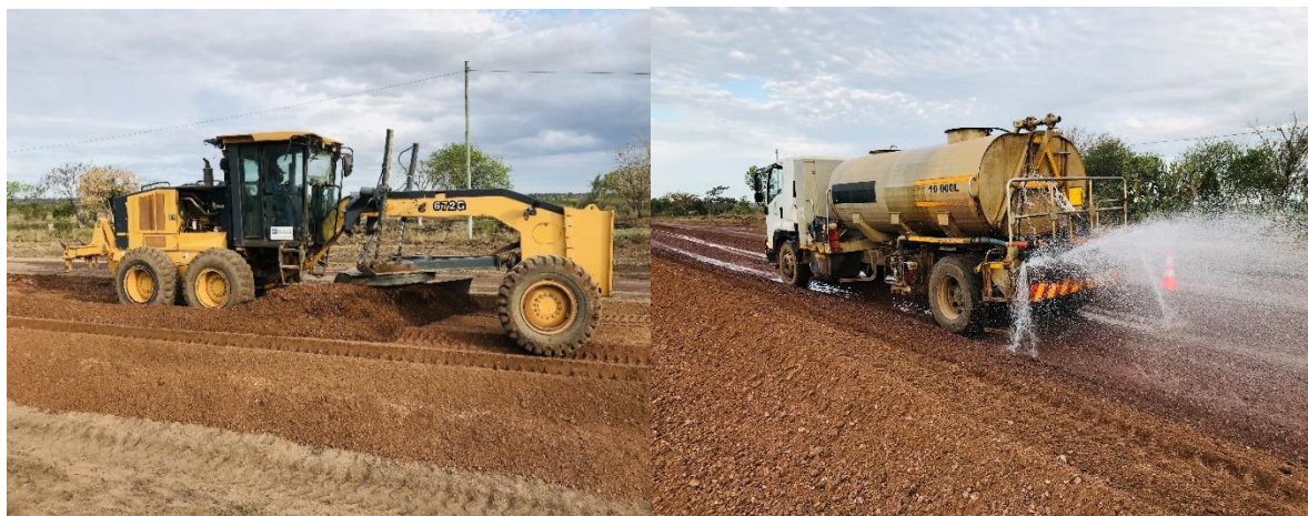
Figura 27. Processamento do material escarificado. (Autor 2021.)
