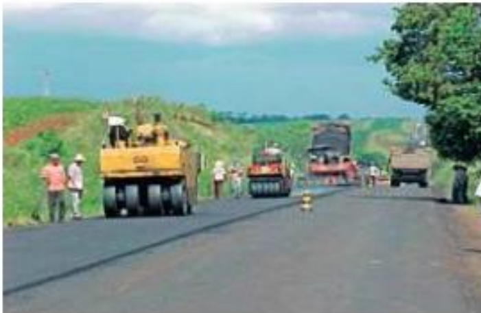
Figura 20. Processo de recapeamento. (BERNUCCI, 2008)
