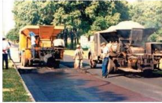
Figura 19. Aplicação de lama asfáltica. (BERNUCCI, 2008)
