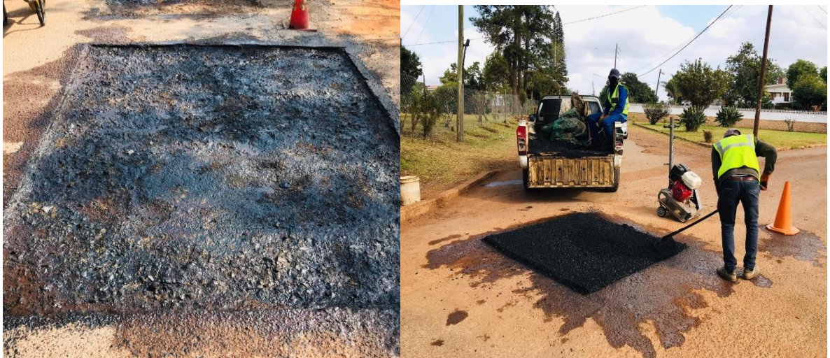
Figura 40. Rega de impregnação MC30 (80/100), Aplicação do Betão Betuminoso e regularização. (Autor 2021.)
