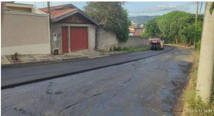
Figura 21. Processo de recapeamento. (Município de espírito Santo do pinhal, visitado em 24.07.2023)
