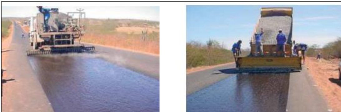
Figura 18. Aplicação de ligante(1), Distribuição de agregados(2). (BERNUCCI, 2008)
