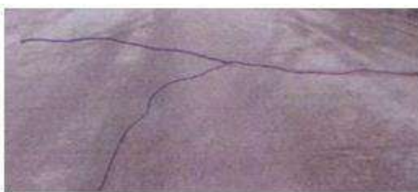
Fig. 14: Elevada Aderência Betão/Sub-base. (Fonte: Silva, 2008)
