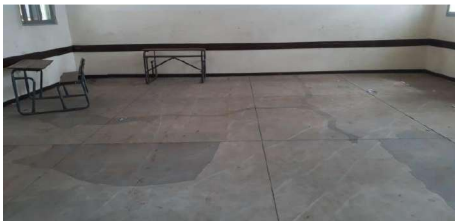
Fig 4: Pavimento de uma sala de aulas em betão. (Fonte: Autor)
