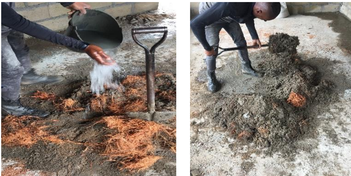
Figura 32: Mistura de solo, fibra e ligante
