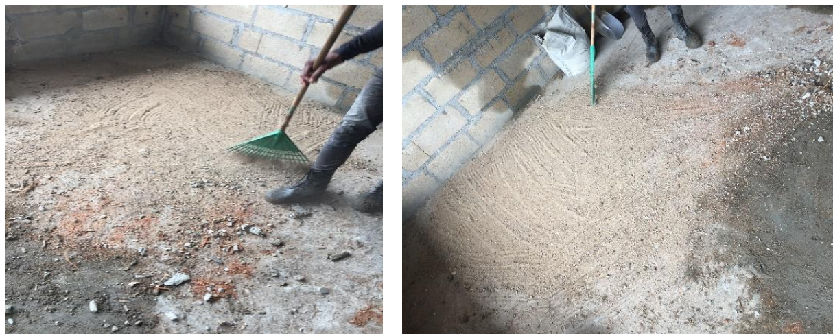
Figura 27: Nivelamento do local de armazenamento dos blocos
