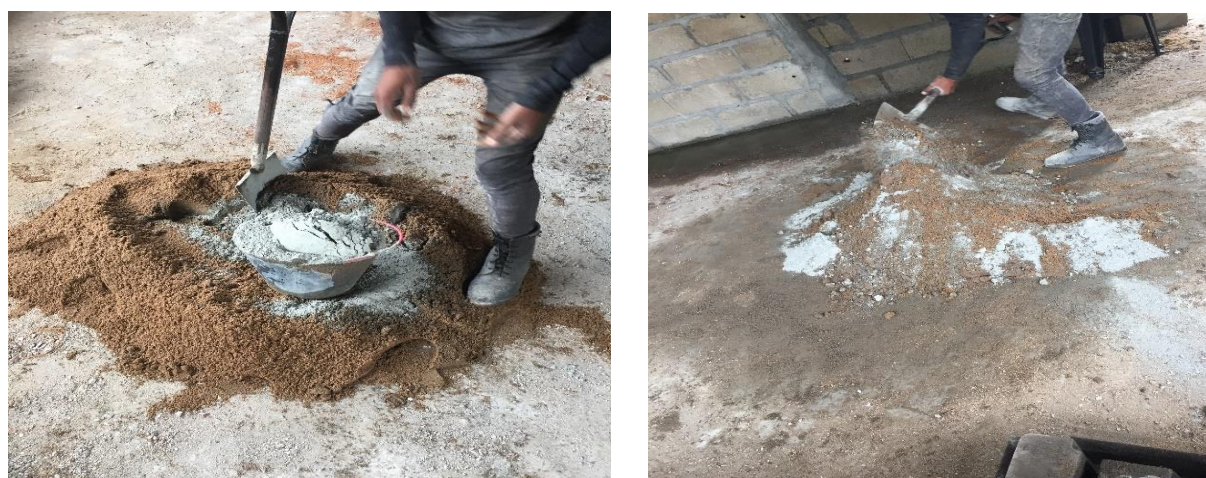
Figura 28: Dosagem e mistura dos materiais para produção do bloco de solo-cimento LF
