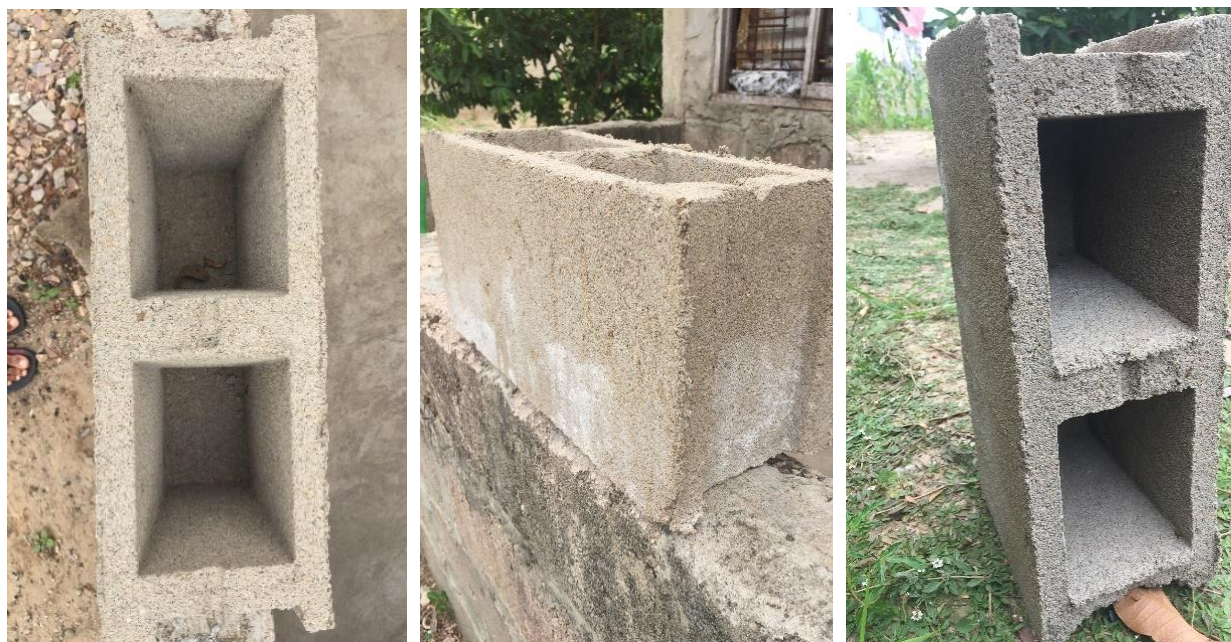
Figura 42: Teste de inspeção visual LF
