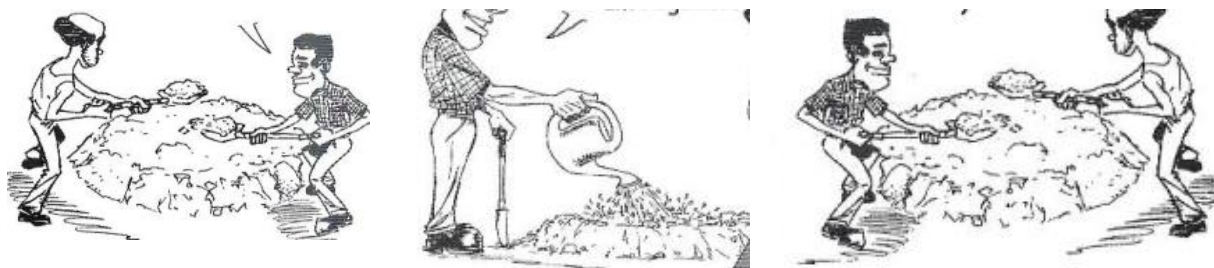
Figura 8: Mistura para obtenção de argamassa para fabrico de blocos de solo-cimento
