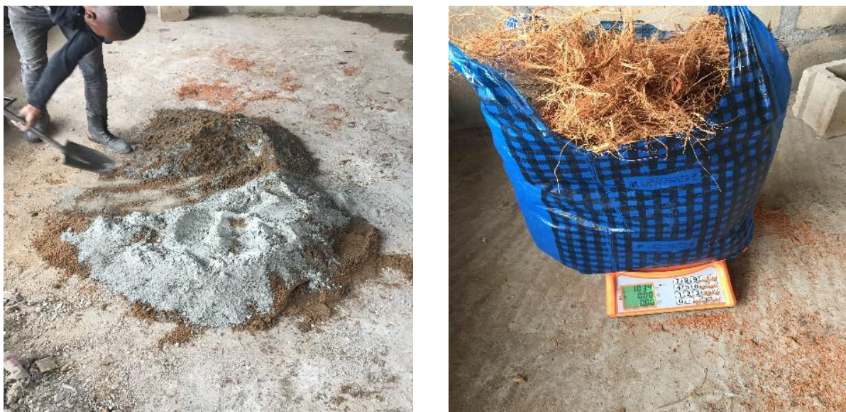
Figura 31: Mistura de solo e ligante, pesagem da fibra
