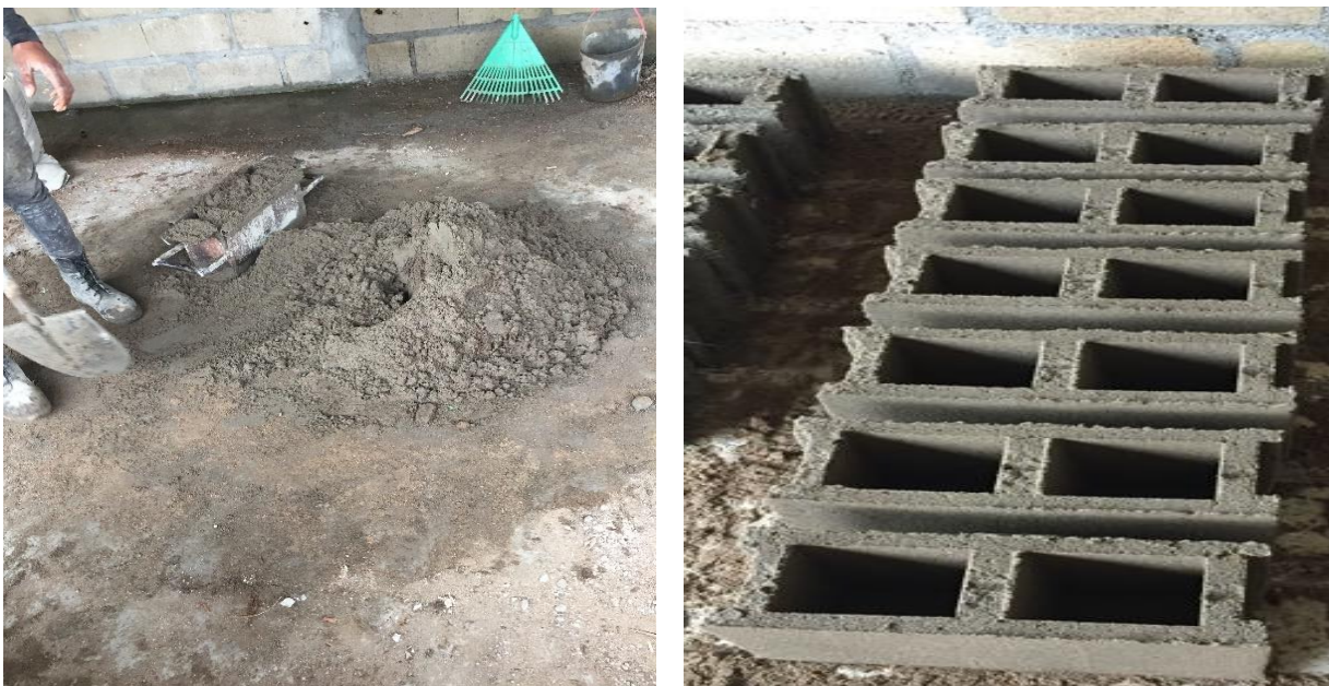
Figura 29: Enchimento e bloco solo-cimento para LF
