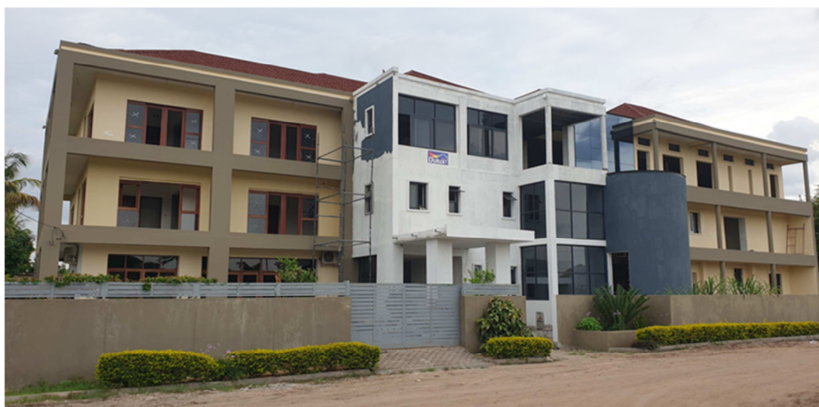
Figura 6: Fachada do hotel (Fonte: Autor, 2023).
