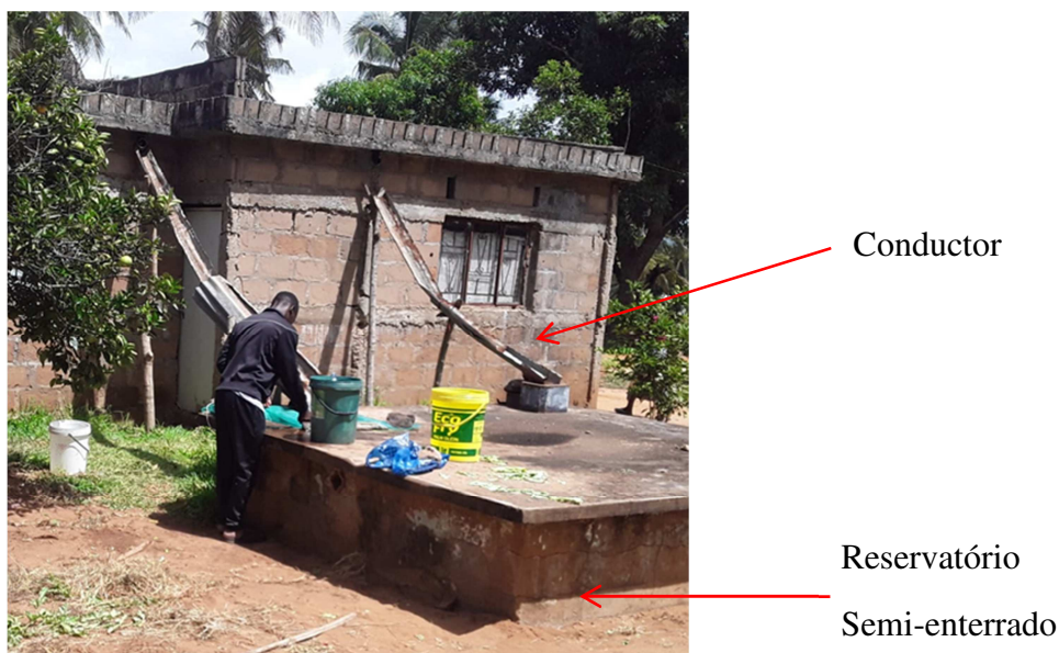
Figura 2: SAAP usado na vila de Chissibuca (Fonte: Autor, 2023).
