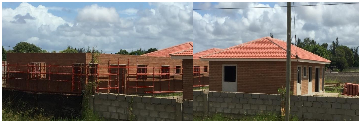
Figura 2: Residências T2 e T3 de alvenaria estrutural sendo construídas em Chiango
