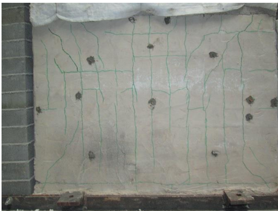
Anexo 4: Provete 2 – Padrão de fissuração na face não exposta
