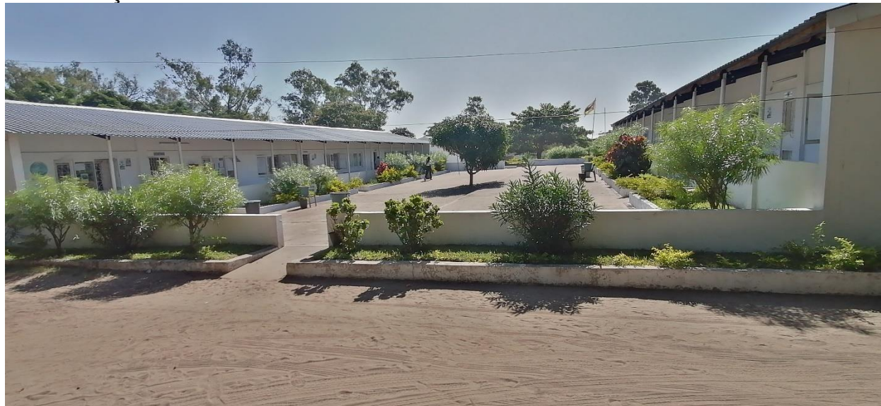
Figura 2: Pavilhão principal da Escola Secundaria ADPP “NCV”
