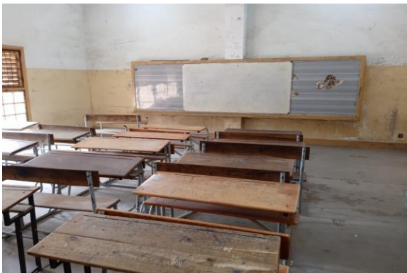
Fig.3: Fachada salas de aula
