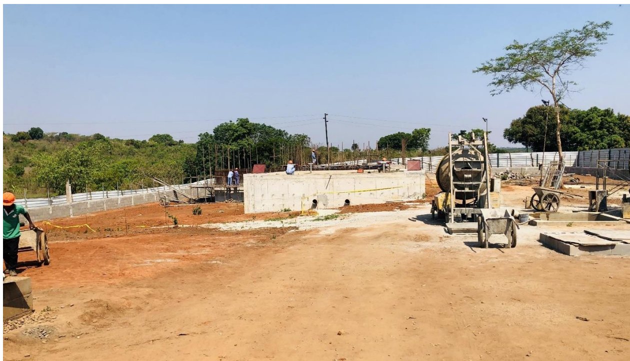
Figura 11. Imagem do recinto a ser implantada a ETA. Fonte: Autor (2021).
