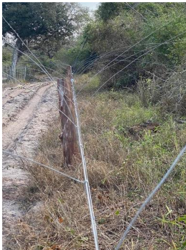
Figura 3. A 'vedação porco-espinho', à prova de elefantes, recentemente concebida e erguida
