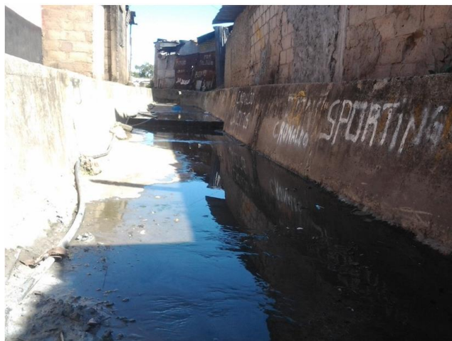
Figura 4. Uma das valas de drenagem do bairro.
