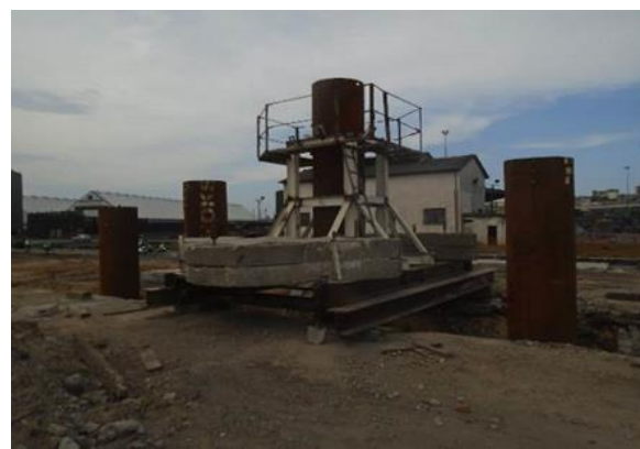
Figura 5: Transporte, descarga e colocação na guia da cravação de tubo molde ou camisa metálica (Fonte: MEECA e Autor deste trabalho, 2020)
