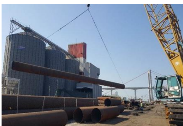
Figura 5: Transporte, descarga e colocação na guia da cravação de tubo molde ou camisa metálica (Fonte: MEECA e Autor deste trabalho, 2020)
