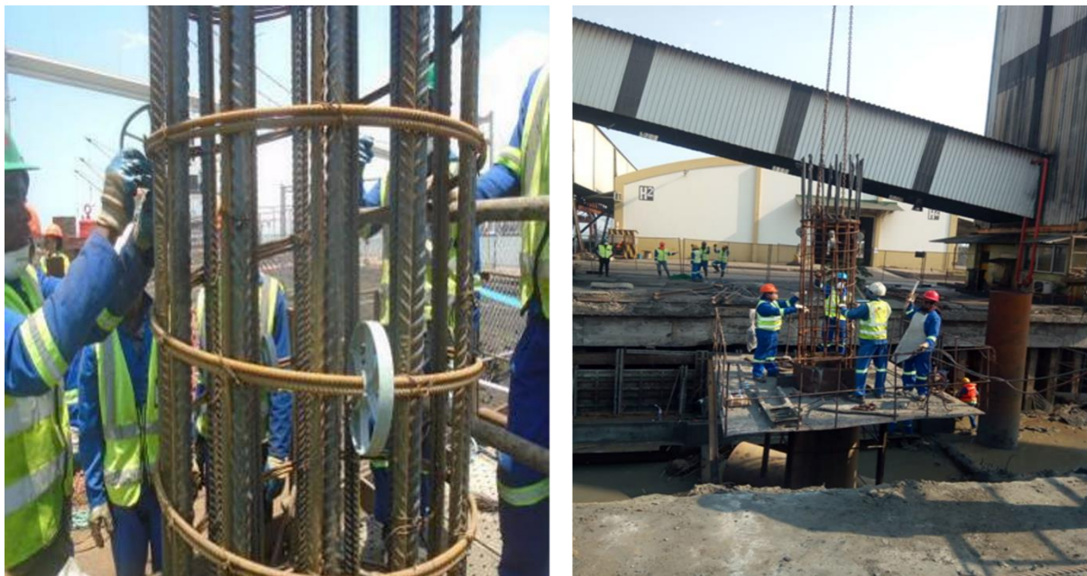
Figura 9: Espaçadores na armadura (Fonte: Autor deste trabalho)
