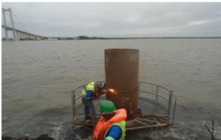
Figura 11: Corte do tubo/Camisa metálica da estaca (Fonte: Autor deste trabalho, 2020)
