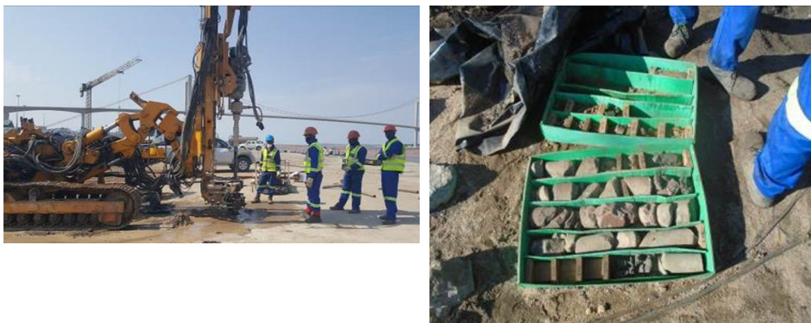
Figura 29: Execução de Carotes à esquerda e amostragem de carotes à direita (Fonte: Autor deste trabalho)
