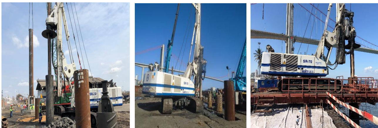
Figura 7: Furação e limpeza da estaca com equipamento da Soilmec SR70 (Fonte: MEECA, 2020)
