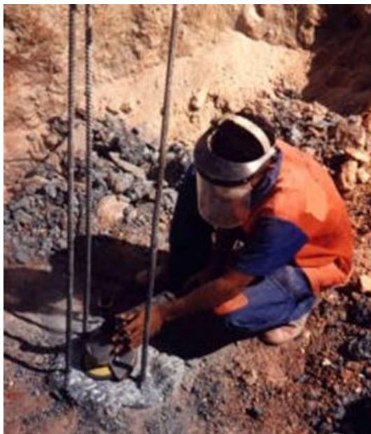
Figura 17: Preparação da Superfície da Estaca (Fonte: PDI Engenharia, acesso: 2022)
