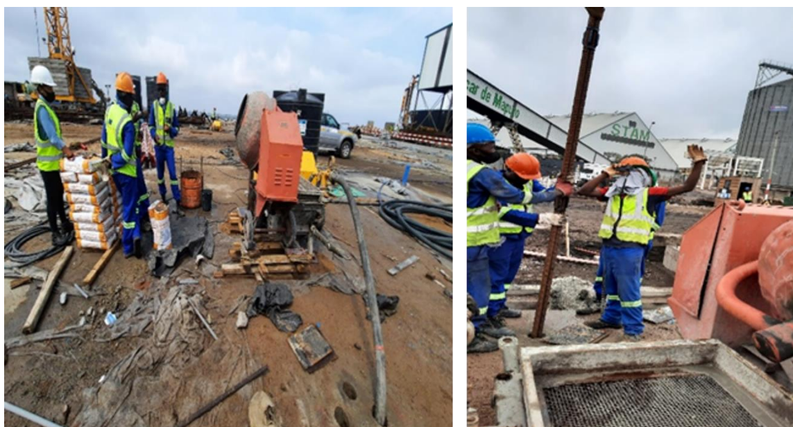
Figura 30: Selagem da Estaca com grout à esquerda e Colocação da Armadura à direita (Fonte: Autor deste trabalho)
