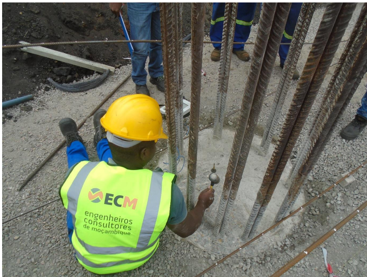
Figura 26: Execução dos Ensaios de Integridade (Fonte: Autor deste trabalho)
