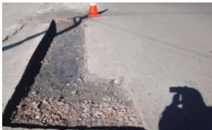
Figura 24: Tratamento superficial para correção do desgaste do pavimento, Fonte (autor 2022)
