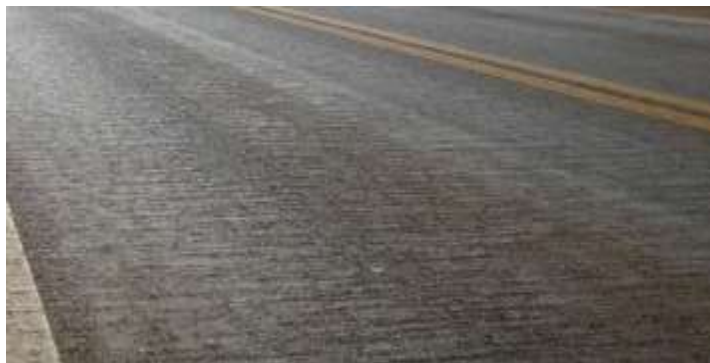
Figura 13: Corrugações ou ondulação numa via (Das Neves, 1983)
