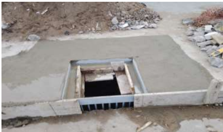
Figura: Construção de uma sarjeta de uma boca.
