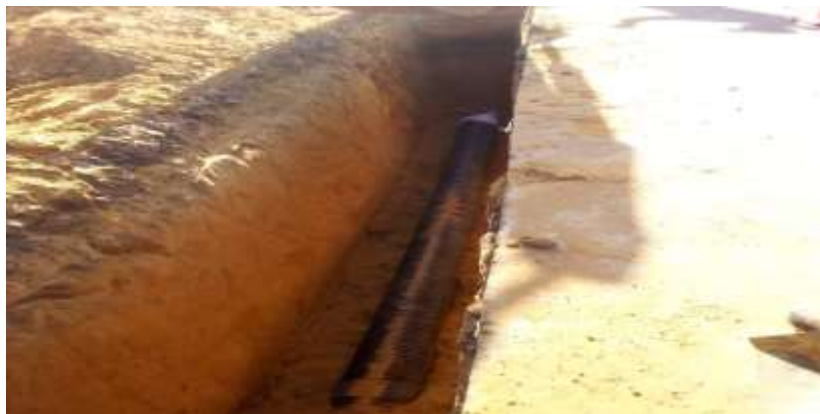
Figura 27: substituição de colector subterrânea Fonte (autor 2022)
