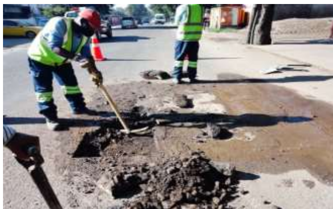
Figura 22: Corte para o tapamento de defeitos de desagregação do pavimento, Fonte (autor 2022).
