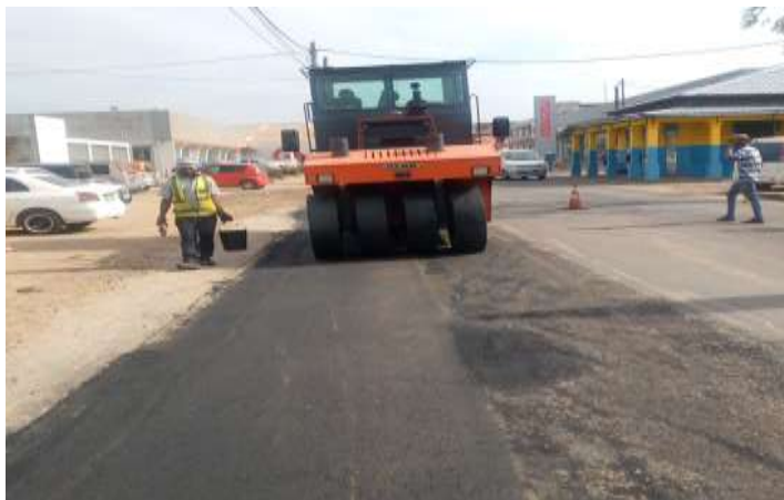
Figura 38: compactação pelo rolo pneumático. (Fonte Autor 2022).
