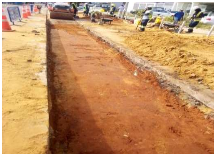
Figura 32: Compactação da sub-base e da base em tout-vennant estabilizado quimicamente com cimento Portland normal 42,5 Mpa. Fonte (Autor 2022).
