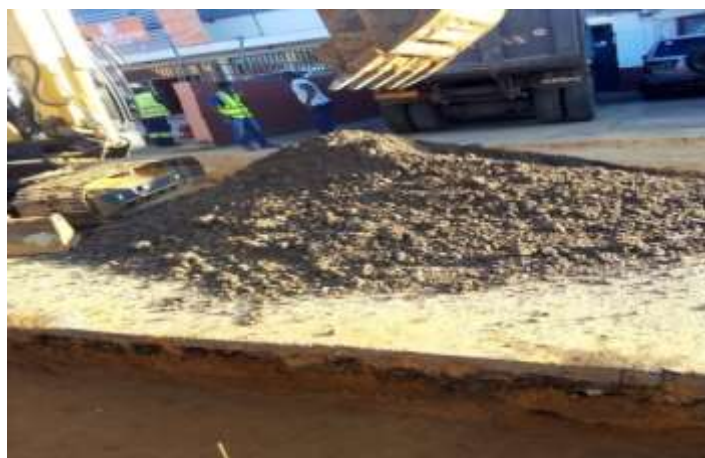
Figura 29: Remoção dos solos de base contaminada, Fonte (Autor 2022).
