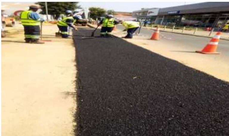
Figura 36: Aplicação do revestimento final, Fonte: (Autor,2022)
