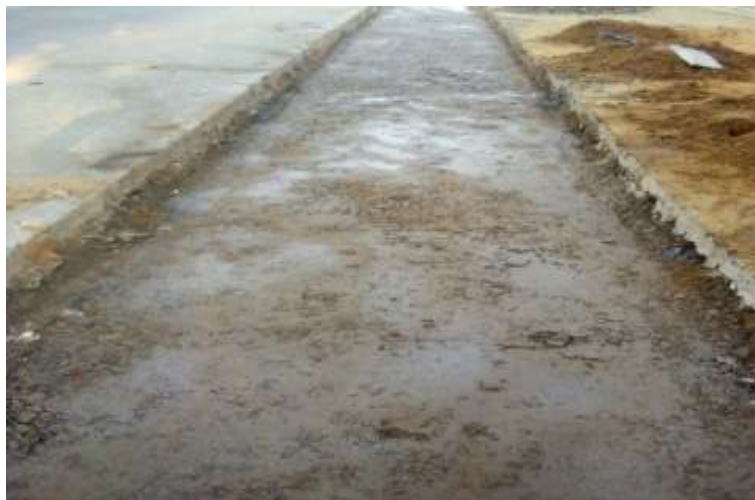
Figura 34: compactação da base, Fonte (Autor 2022).
