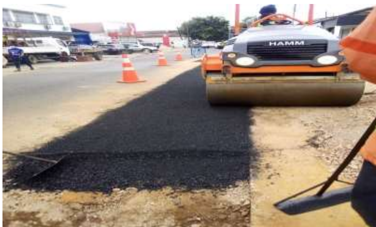
Figura 37: Reconstrução da base com rolo liso, (Fonte Autor, 2022).
