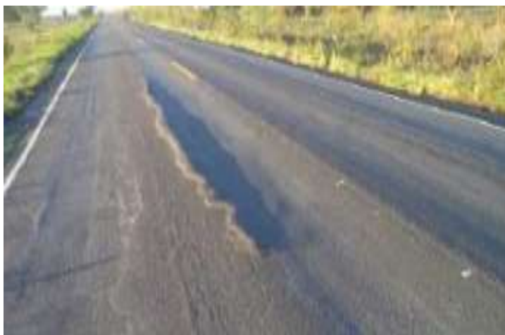
Figura 8: Refluimento do ligante numa via, (MEDINA, 1997).
