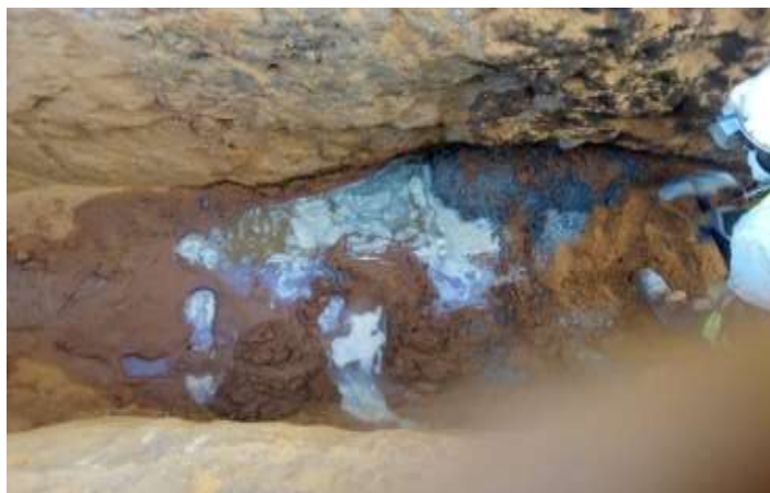
Figura 25: Drenagem entupida com óleo de motor, Fonte: (Autor, 2022).
