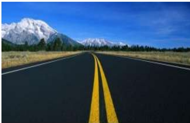
Figura 4: Estrada revestida com material betuminoso, (MACOPAV).
