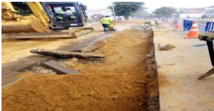
Figura 28: Corte e remoção de base contaminada Fonte: (Autor, 2022).
