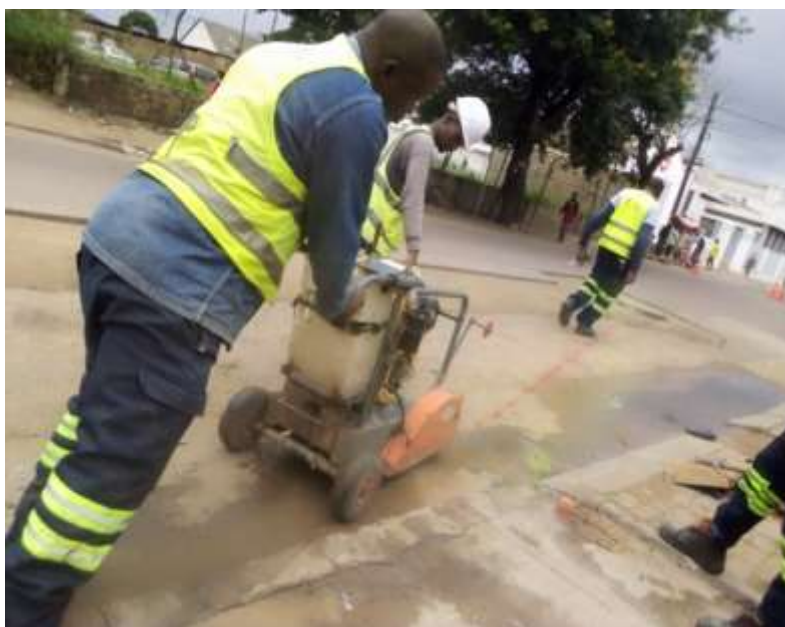
Figura 30: Corte do asfalto utilizando a máquina de corte do pavimento, Fonte: (Autor, 2022).
