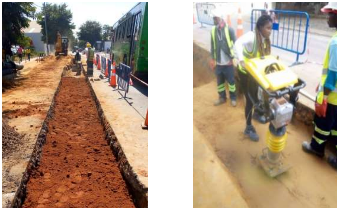
Figura 31: Estabilização mecânica da sub-base, Fonte (Autor).
