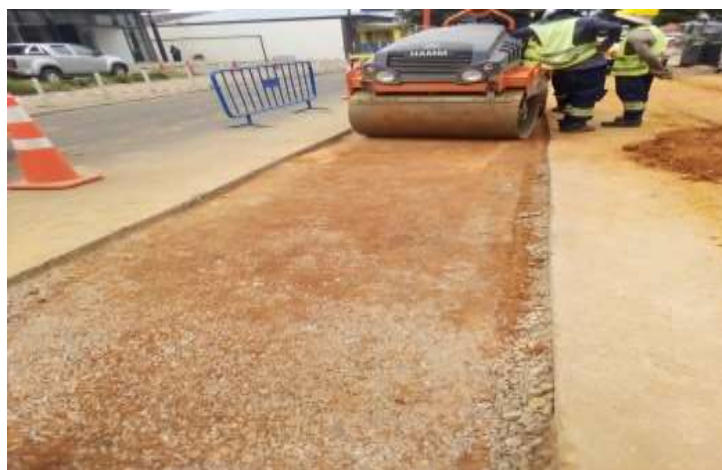
Figura 33: Compactação de base estabilizada. Fonte (autor 2022)
